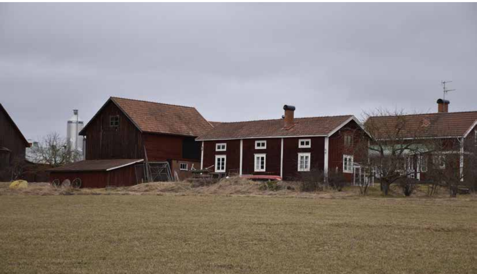
Ålderdomlig parstuga vid kringbyggd gård i Vagnäs. Byggnaden har bevarad karaktär från 1800-talets senare hälft. Vagnäs 4:7.
