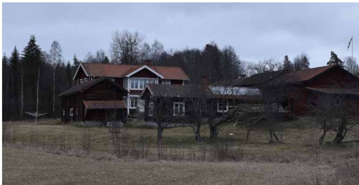
Trons i Åjer är fyrkantsbyggd med intakt månghussystem. Bostadshuset har renoverats i senare tid men är i grunden en ålderdomlig parstuga. Åjer 10:3.
