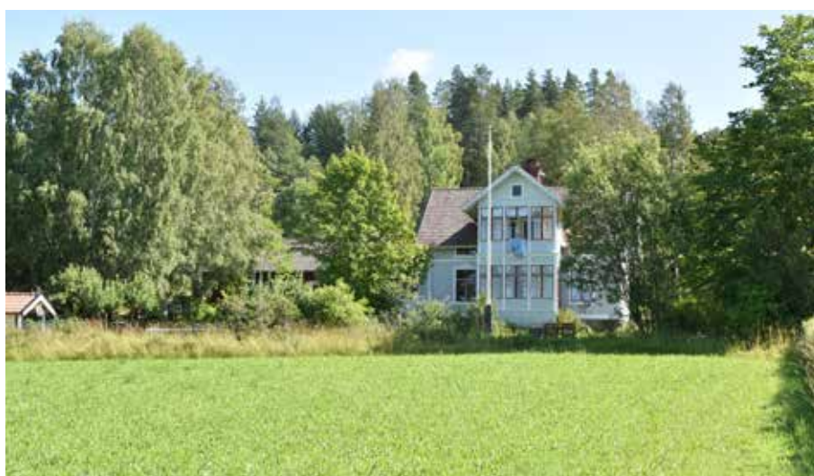
På vissa platser i byn finns äldre hus i snickarglädestil med linoljemålad ljus fasspontpanel. Byggnaderna är värdefulla bland annat eftersom de ofta är byggda med en hög utformningsmässig kvalitet och bör därför bevaras i befintligt skick. Tibble 9:9.
