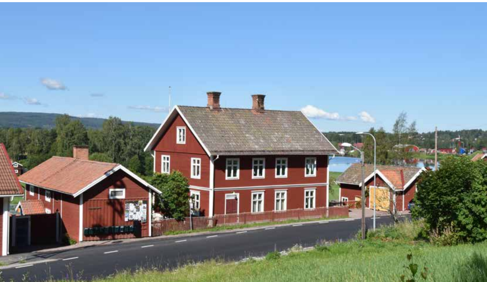
Dubbelkorsplanshus som förut varit lanthandel. Byggnaden kan berätta om industrisamhällets etablering i Leksandsbygden och bedöms därför ha särskilt kulturvärde. Tibble 44:7.
